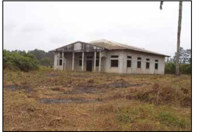
Un chantier abandonné à Mossendjo.
